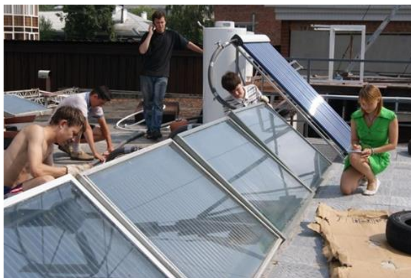
Рис. 1. Гибридная теплогенерирующая установка
