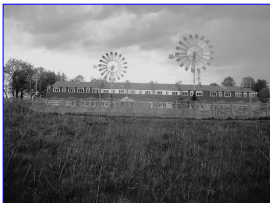
Рис. 1. Вид на «Энергоэффективный дом»
