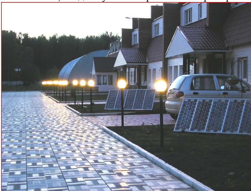
Рис. 3. Освещение территории «Энергоэффективного дома» LED – светильниками
