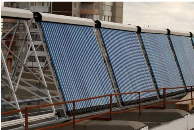
Рис. 3. Вакуумный солнечный коллектор
