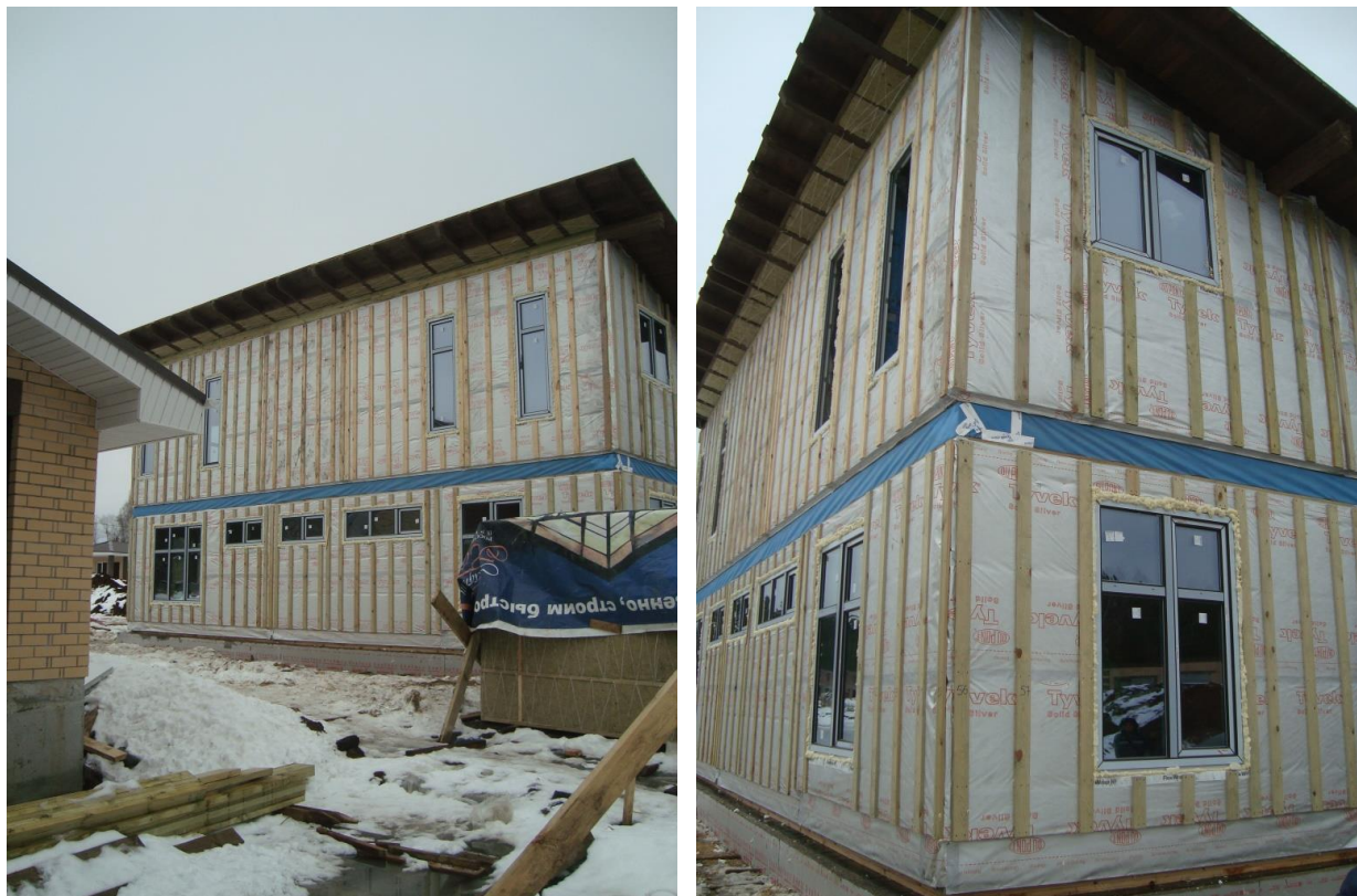
Рис. 1. Внешний вид «Дома А +» на этапе строительства (ноябрь 2014 г.)
