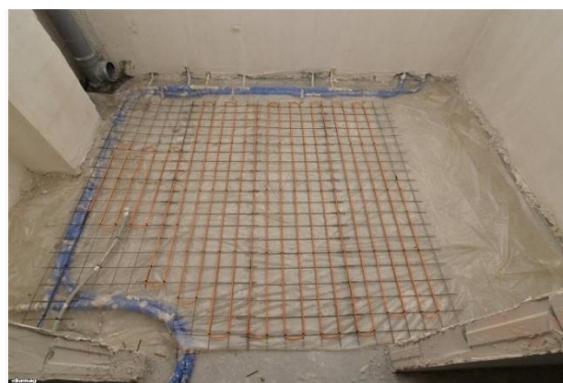
Рис. 2. Монтаж теплого пола в доме с электроотоплением
