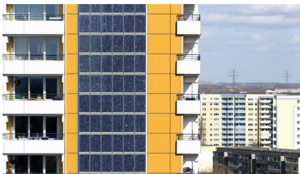
Рис. 1. Фотоэлектрические панели на фасаде здания
