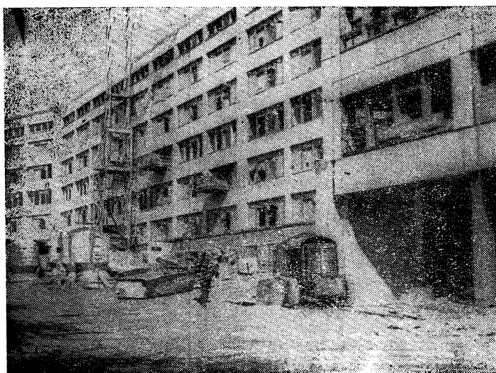
Новый корпус УрГУ. Идут отделочные работы.
