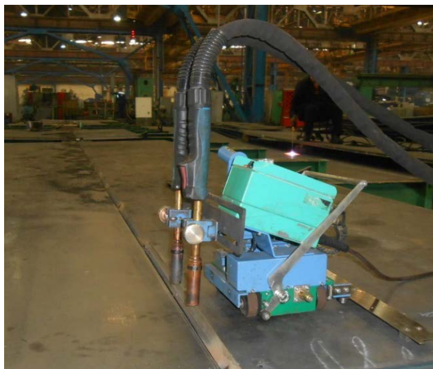
Рис. 29. Сварка протяженных швов автоматом для двухдуговой сварки тракторного типа
