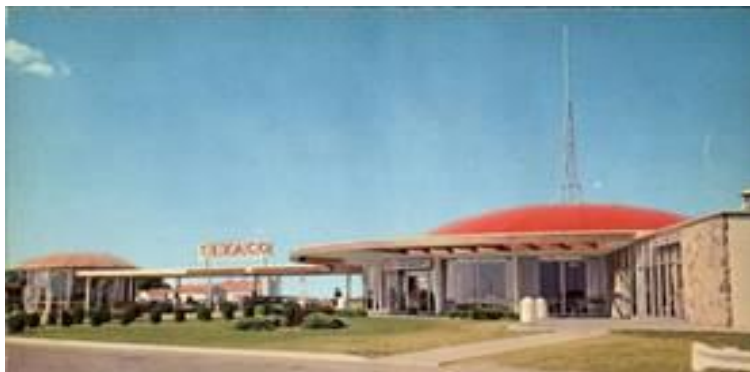
Рисунок 1 – Объект дорожного сервиса в Техасе. Круглый фасад с кровлей, имитирующий шатер [22]
