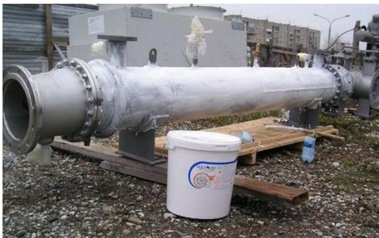
Рис. 2. Внешний вид трубопровода с нанесенным термоизолирующим покрытием «Изоллат»
