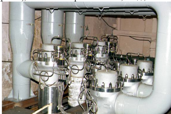
Рис. 1. Импульсные предохранительные устройства ПГ
