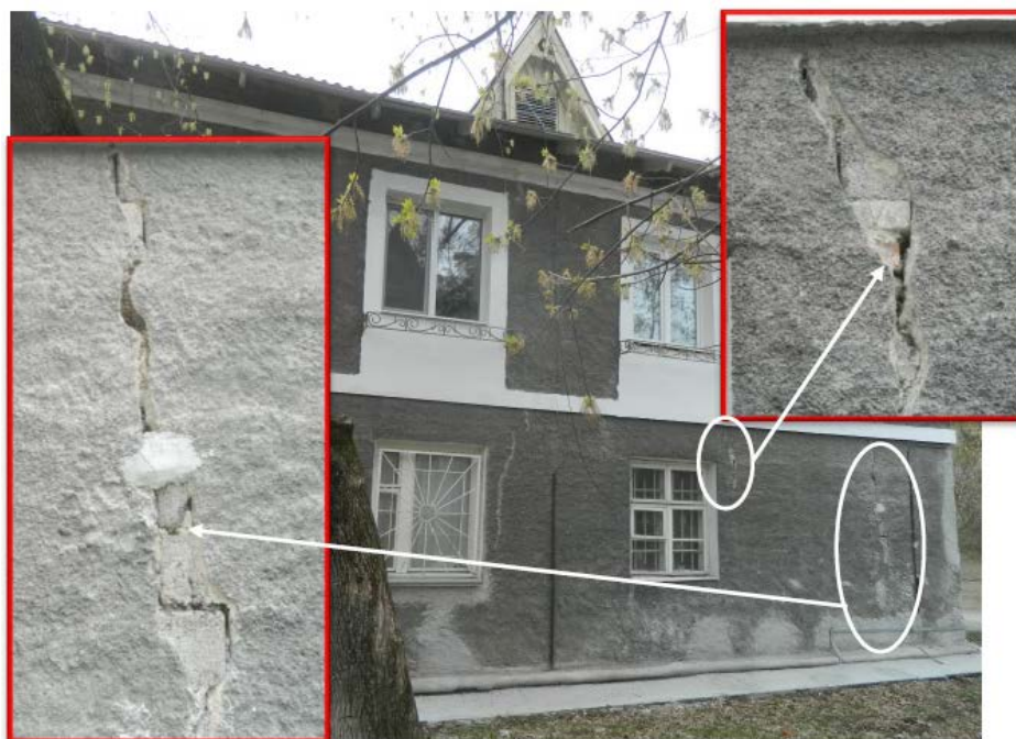
Рис. 4. Разрушение стен
