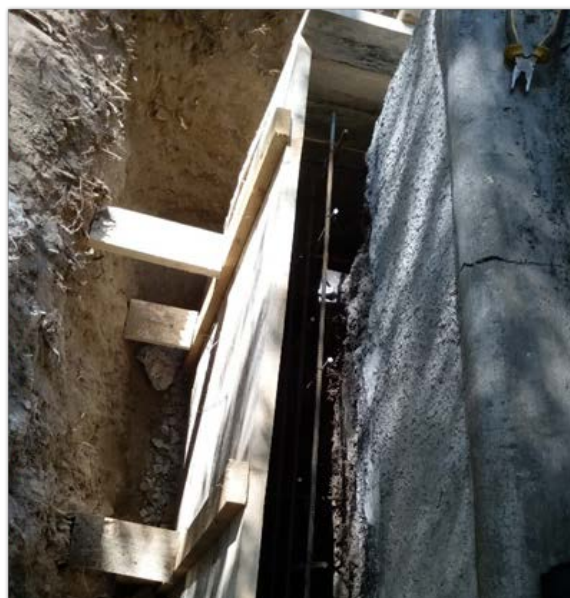
Рис. 8. Установка опалубки
