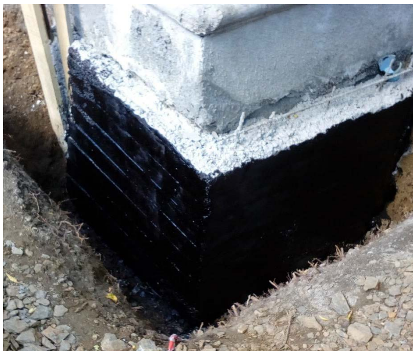
Рис. 9. Гидроизоляция бетонных поверхностей
