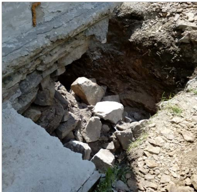
Рис. 5. Разрушение бутовой кладки
