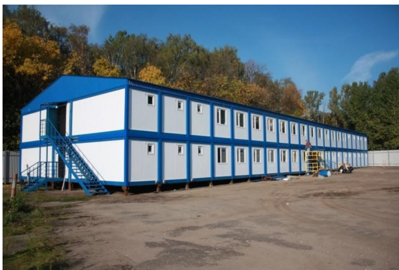
Рис. 10. Здание вахтового поселка из блок-контейнеров. Россия
