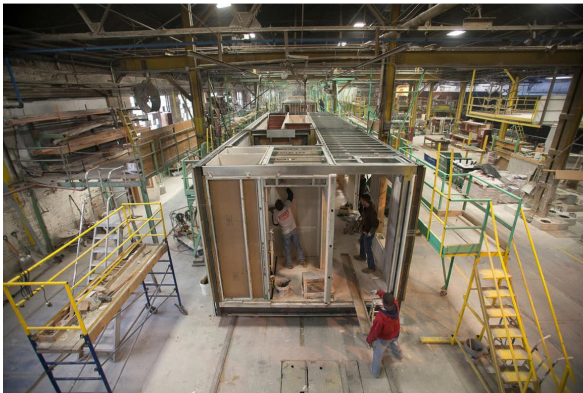
Рис. 11. Сборка блок-модуля из легких конструкций
