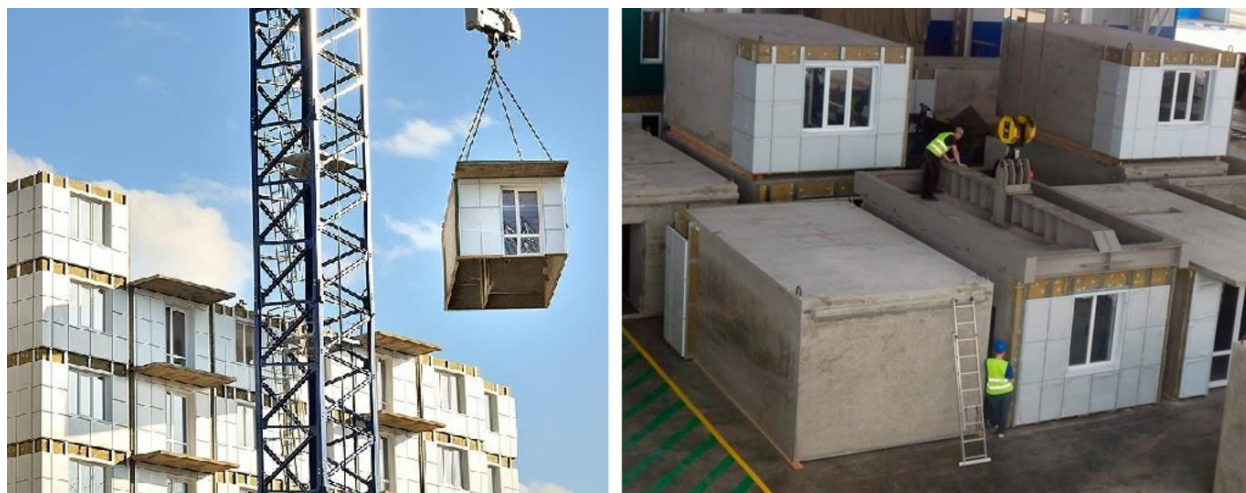
Рис. 8. Возведение жилого дома из железобетонных ОБ производства Выбор-ОБД
