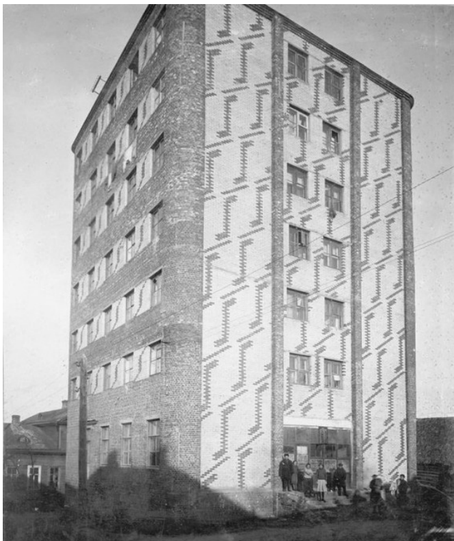
Дом РЖСКТ „ТРУД“ Башня-коммуна Почтамтская ул.
