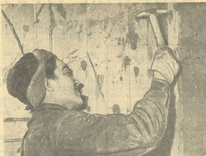
Студент архитектурной специальности Николай Одетов на стройке один из лучших штукатуров, работает по чет-вертому разряду.
