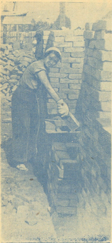
Сортировка кирпича на строительстве котельной во Втузгородке.
