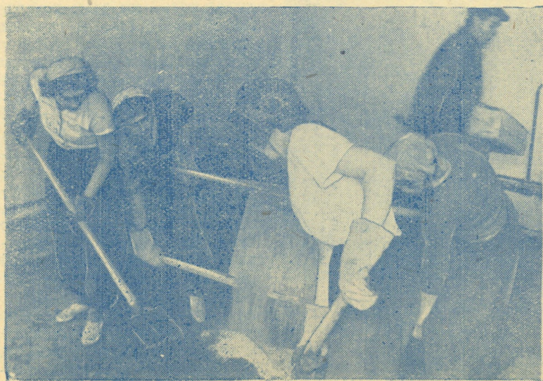
Лучшая бригада на бетонных работах в третьем учебном корпусе.
