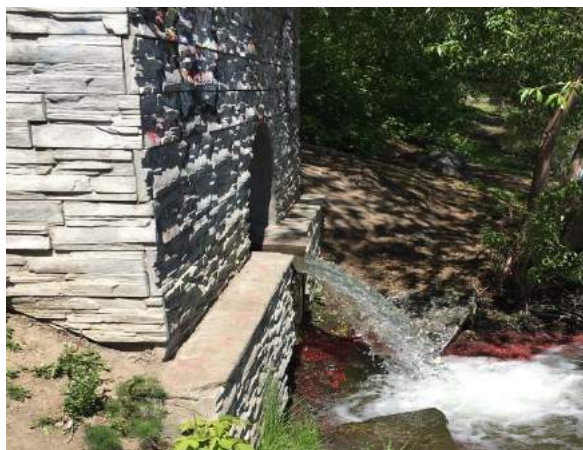
Фото 2. Выход коллектора реки Малаховки
