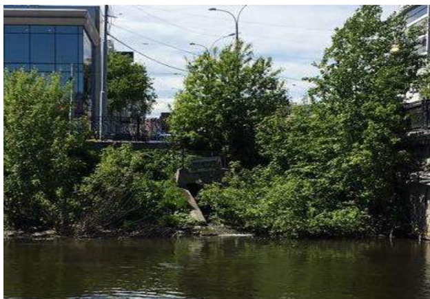
Фото 3. Выход коллектора ливневой канализации на ул. Малышева
