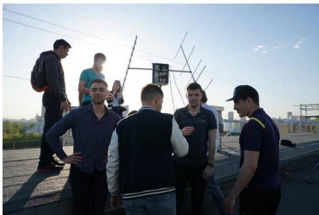
Рис. 1. Установка и настройка антенной системы на крыше здания университета
