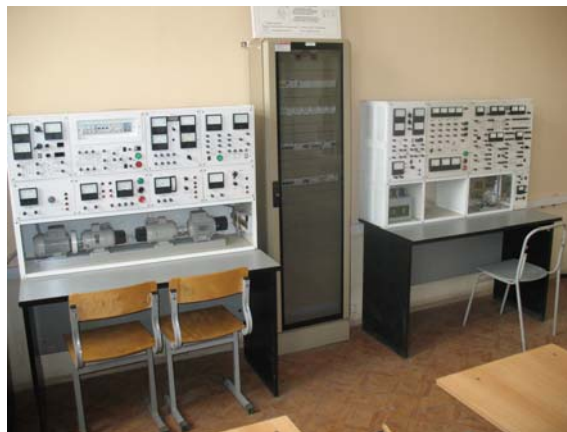
Рис.2. Лаборатория электромеханики и электроснабжения
