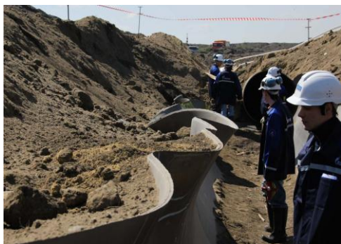
Рис. 1. Вязкое трещинообразование трубопровода
