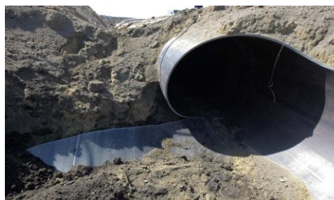
Рис. 2. Остановка вязкого трещинообразования закольцовыванием
