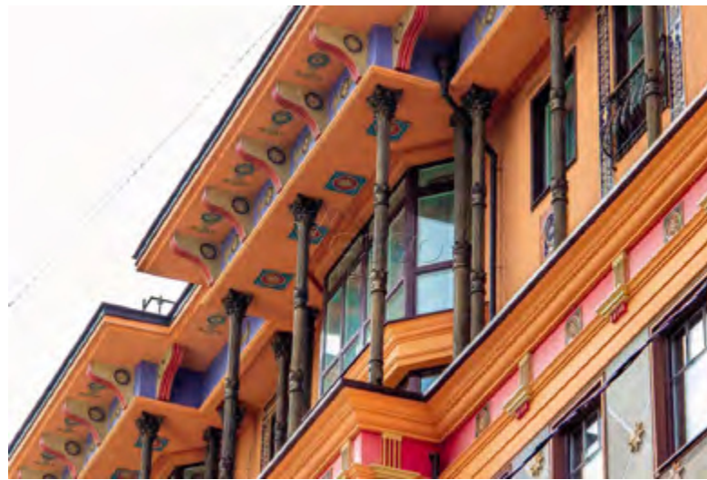
^ Рис. 14. Дом Amorini Dorati («Помпейский дом»). Фрагмент. Москва, Филипповский переулок, 13. Архитектор М. А. Белов. 2005
