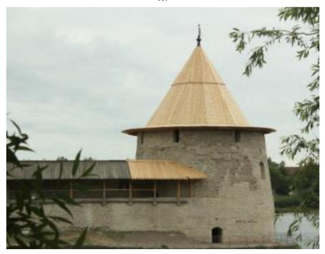
Рис. 113. Псков. Башня Плоская в составе Ансамбля Кремля после реставрации. Фактура облицовки позволяет отличить подлинную кладку от реставрационной. Фото автора, 2019 г.
