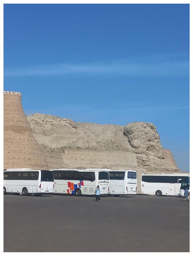
Рис. 60. Узбекистан. Бухара. Стены крепости. Слева — восстановленный участок, справа и в центре — руинированная подлинная каменная кладка. Фото автора, октябрь 2023 г.
