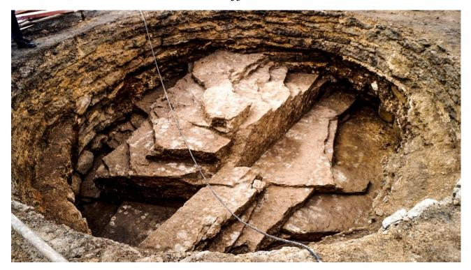
Рис. 46. Конструкции внутренней башни, скальное основание. Фото автора,  $2016 \, \Gamma$ .
