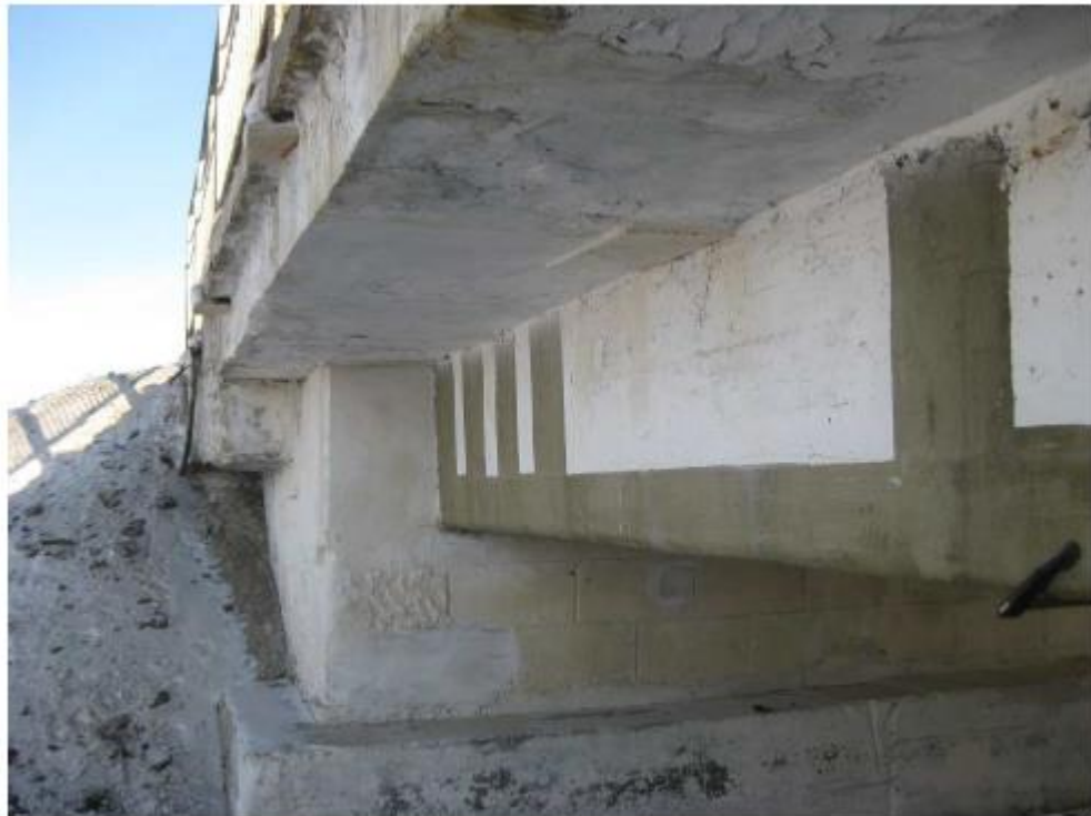
Рис. 7. Усиление конструкции моста приклеиванием ламината из углеродного волокна
