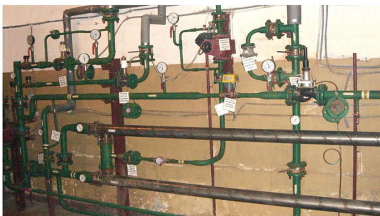
Рис. 3. «Планшетный» ИТП размещен в плоскости стены
