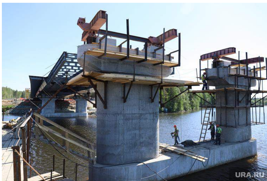
Рис. 8. Возведение железобетонных опор
