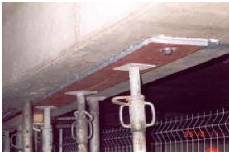
Рисунок 1.3. Элемент из стального листа, используемый для армирования железобетонных балок
