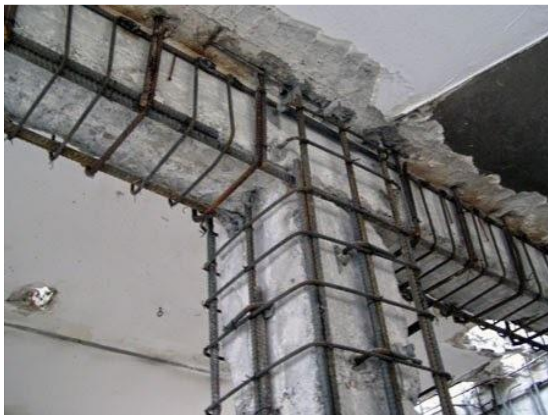
Рисунок 1.2. Железобетонная оболочка колонны и ее опорных балок
