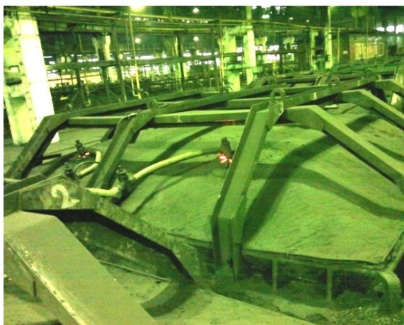
Рис. 4. Общий вид свода на печи обжига
