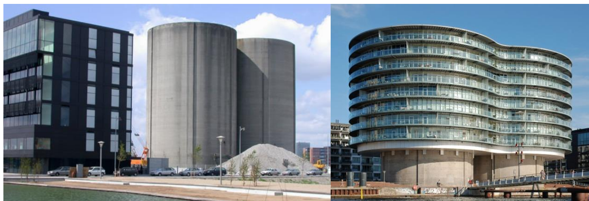
Рисунок 2 – Силосы до (слева) и после (справа) реконструкции под жилье [7]
