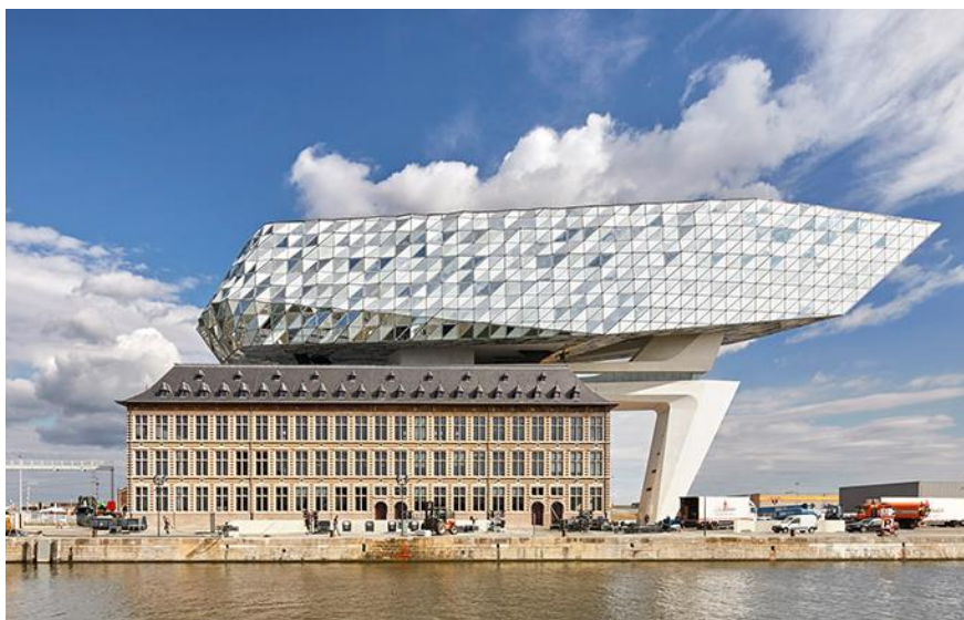
Рисунок 5 – Реконструкция пожарной станции в порту Антверпена, Бельгия [10]
