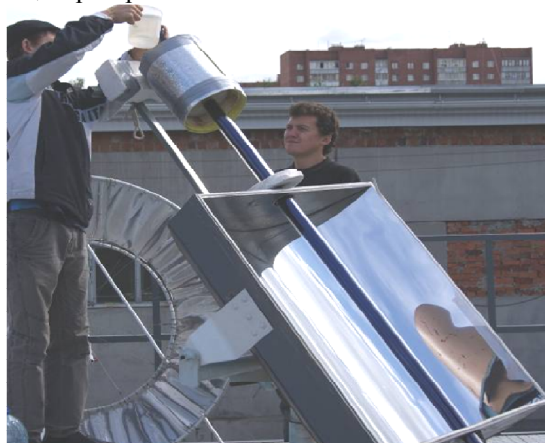
Рис. 1. Проведение работ на концентраторах солнечной энергии.
